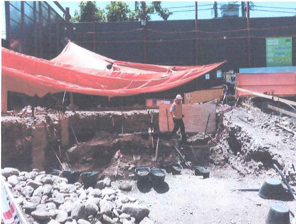
Figura 1. Implementación de placa terciado en la unidad 5C por desmoronamiento.
